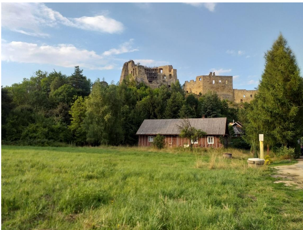
Fot. 19. Ruiny zamku Kamieniec
